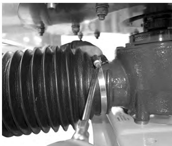
図 16: ジョイントシャフトガードを設置する
