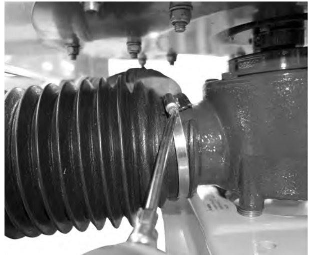
Kuva 16: Nivelakselin suojuksen asennus
