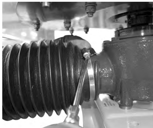
Рис. 16: Установка защитного кожуха карданного вала
