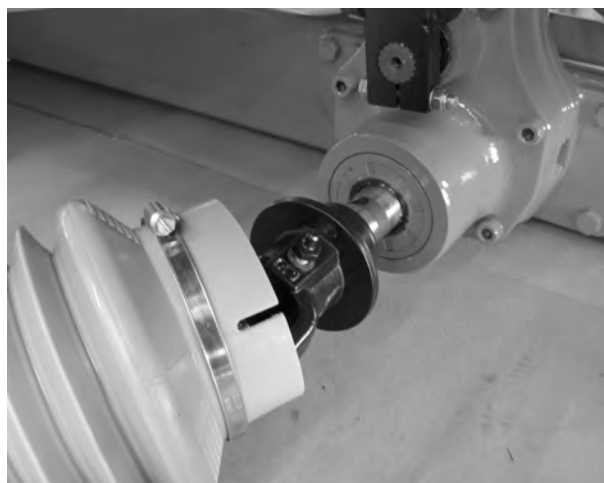
Рис. 12: Встановлення карданного вала на цапфу редуктора
