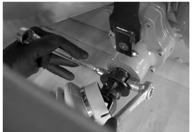
Att. 13: Kardānvārpstas nostiprināšana
