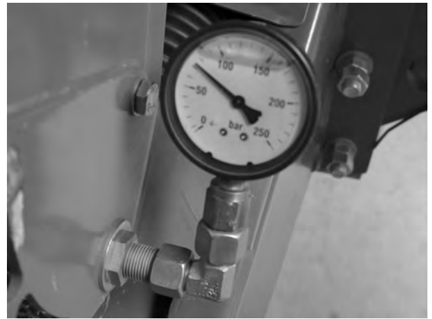
Abb. 122: Manometer an Kabelführung über Deichsel
