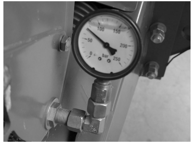
Fig. 103: Manometrul de pe traseul cablurilor de deasupra oiștei
