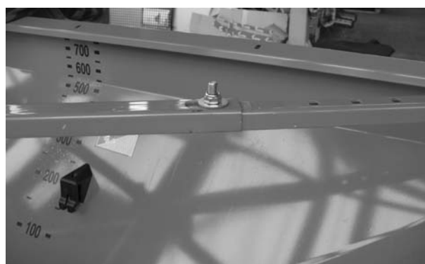
Figura 5.15: Fissare l'elemento centrale della controventatura
