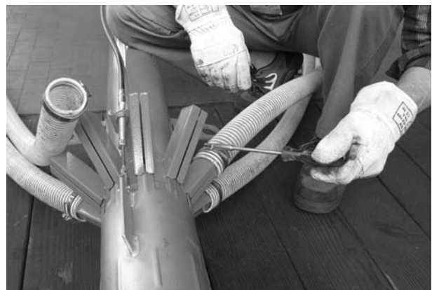
Bild 5.7: Schlauchschellen festziehen
