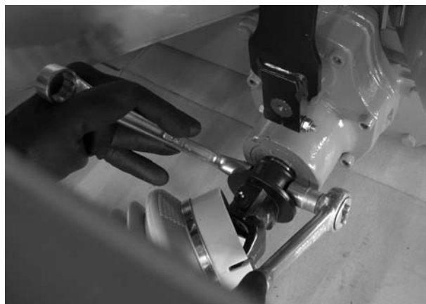
Εικόνα 7.4: Στερέωση αρθρωτού άξονα
