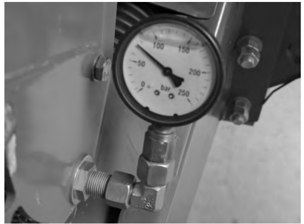
Pav. 115: Manometras ant kabelio kreiptuvo per grąžulą
