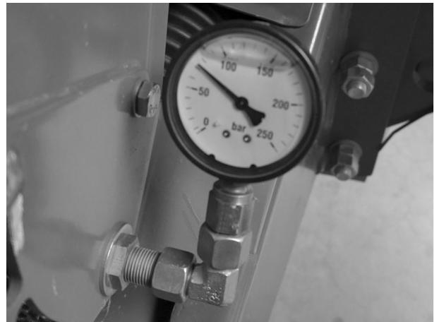
Att. 103: Manometrs pie kabeļa izvada caur jūgstieni
