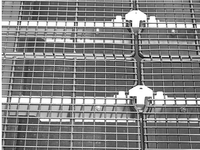
Kuva 6.24: Suojaritilän varmistaminen säiliöön
