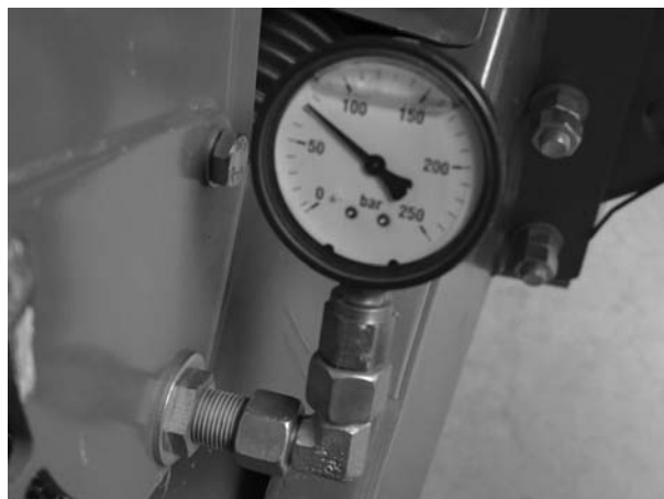
Slika 9.16: Manometar na kabelskoj vodilici iznad rude
